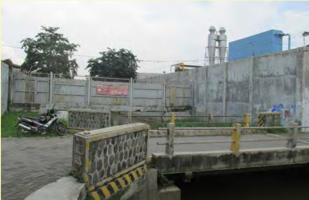
Gambar 29. Pagar Industri yang menutup akses Kali tengah
